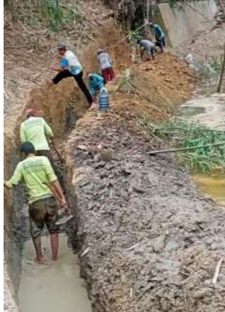
Gambar 2. Pembangunan Saluran Irigasi di Desa Ngadipurwo
